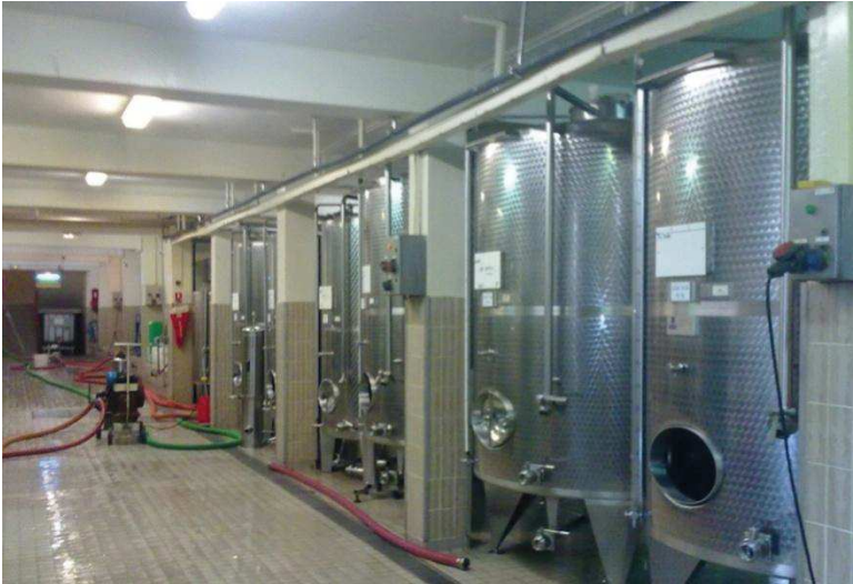
Figure 22 : la cave a été complètement noyée en 2002
