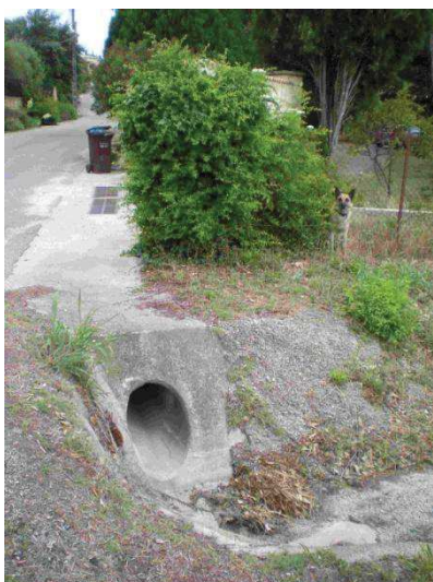
Figure 15 : réseau enterré devant le portail avant évacuation vers la draille
