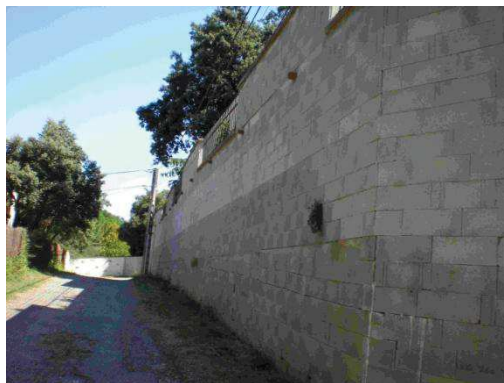
Figure 19 : Mauvaise prise en compte des écoulements, mur en parpaing
