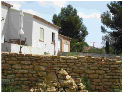
Figure 18 : Mauvaise prise en compte des écoulements, mur en pierre cimenté
