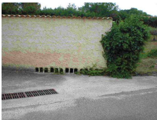
Figure 20 : trous percés en bas du mur après les inondations de 2002. Amélioration de la transparence hydraulique a posteriori
