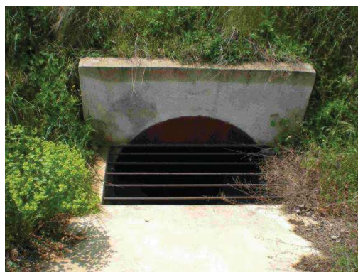
Figure 12 : fonçage à l'est de la RD 228
