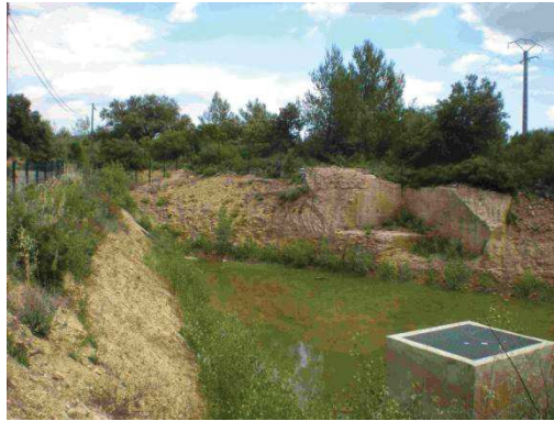
Figure 13 : bassin de rétention au sud de la carrière SNET (récupération du pluvial du vallon de Cournet)
